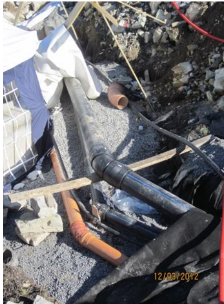
Figur 32 Bend på PE-rør. Foto: Terje Rønneberg.
