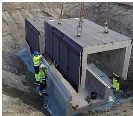
Figur 11 Teknisk kulvert under bygging. Foto: JBV/Daniel Hansen
