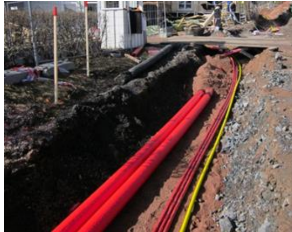
Figur 17 Grøft med blant annet trekkerør. Foto: Terje Rønneberg.
