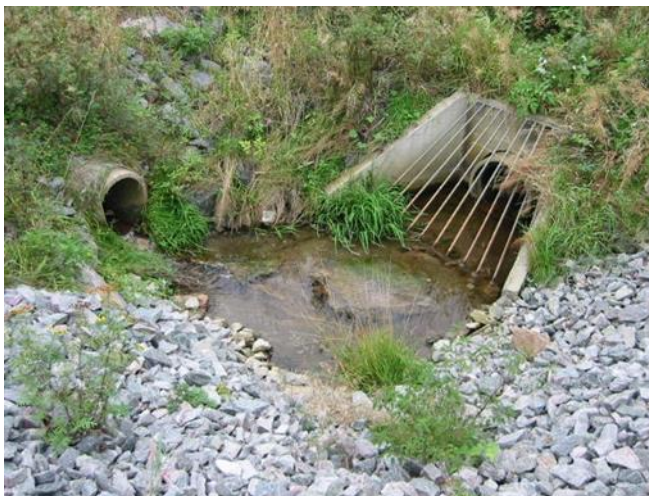
Figur 26 Utløp (til venstre) og bekkeinntak med rist (til høyre). Foto: Eidskog kommune.
