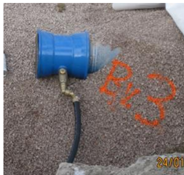
Figur 31 Anboring på vannledning. Foto: Terje Rønneberg.
