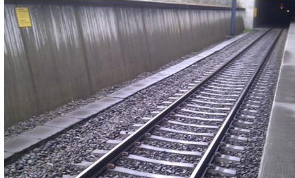
Figur 10 Kabelkanal langs jernbane. Foto: Jernbaneverket.
