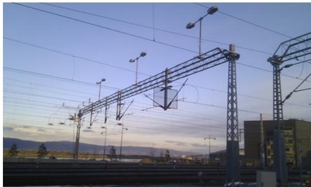
Figur 19 Åk forankra i to master. Foto: JBV/Håvard Moe
