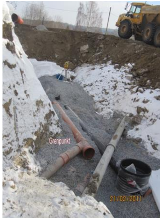
Figur 9 Grøft som ikke er lukket ennå. Foto: Terje Rønneberg.
