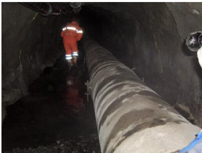
Figur 18 Tunnel. Foto: Terje Rønneberg.
